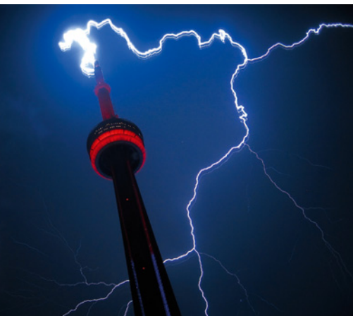
Fig. 27 Para-raios e descarga elétrica na atmosfera.
